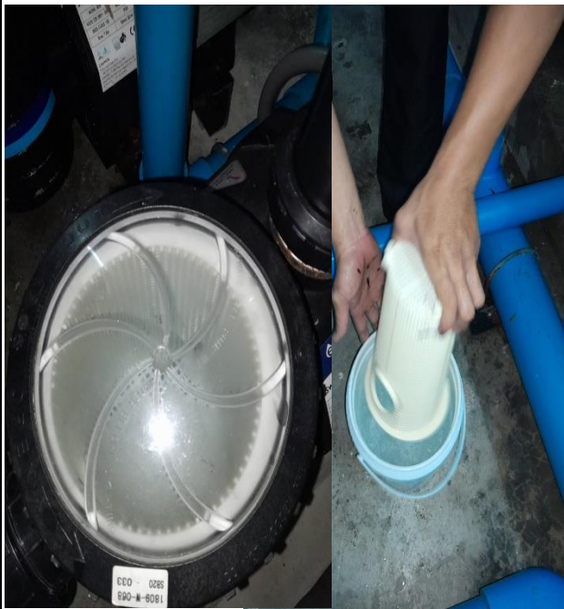
ภาคผนวกที่ 3.29 การทำความสะอาดระบบกรอง น้ำ
