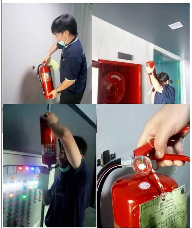
ภาคผนวกที่ 3.34 การตรวจสอบถังดับเพลิง แบบหิ้ว
